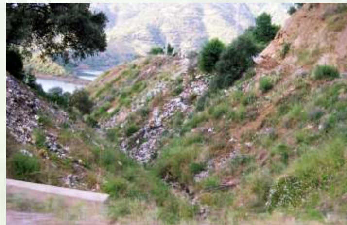
Décharge au barrage de Taksebt
